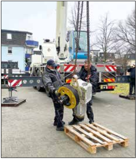
Der Aufzug-Motor wurde per Kran übers Dach herausgehoben.
